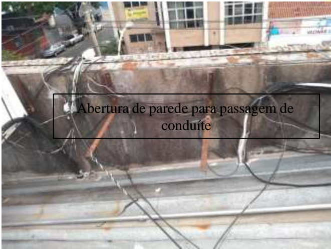
Fiação elétrica exposta com fios decapados sob calha de parapeito conduzindo eletricidade.
