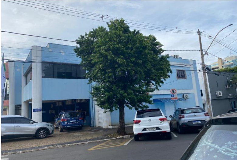
FACHADA LADO DIREITO DA CÂMARA
