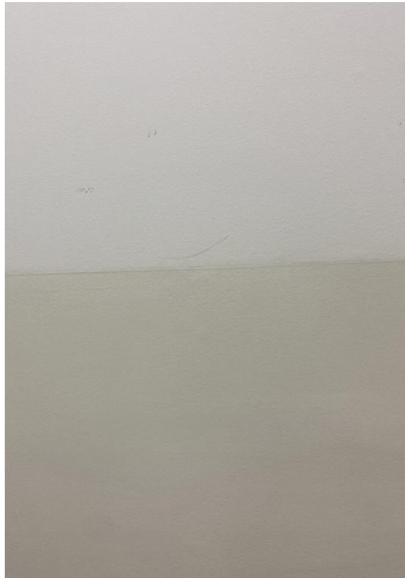
PAREDES INTERNAS DO PRÉDIO DA CÂMARA
