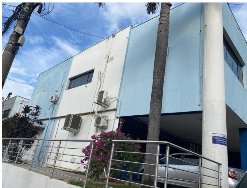
FACHADA LADO ESQUERDO DA CÂMARA
